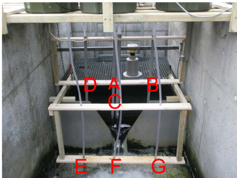
Figur 2 Forsøgsopstilling til udtagning af døgnprøver i afløbsvand fra Bramming Renseanlæg Nord.
