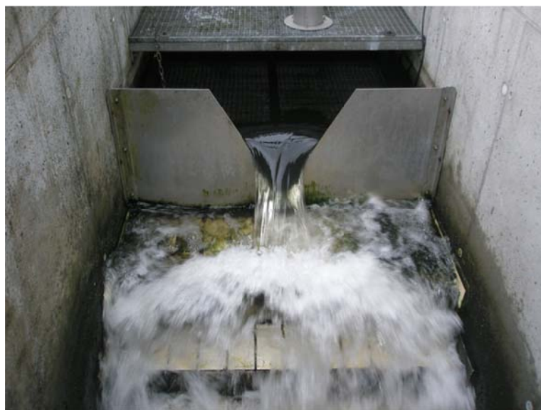
Figur 1 Afløb fra Bramming Renseanlæg Nord.
